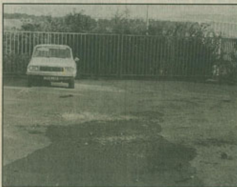
Les transformateurs viennent de la société Auto-Vrac, où 500 mètres carrés de parking ont été souillés, nécessitant le traitement de 75 tonnes de gravats (Photo Marcel GARNIER)
