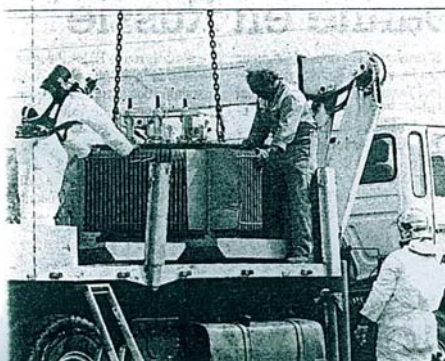
Il a fallu refermer les transformateurs avec le matériel fourni par EDF-GDF avant de pouvoir les déplacer (Photo Dominique Jullian, « Sud-Ouest »)
