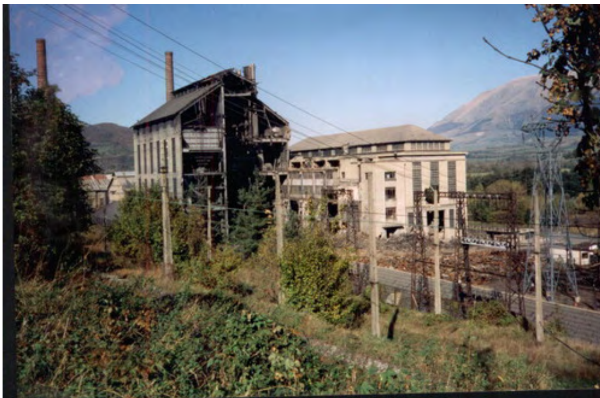
Susville, la centrale thermique du Villaret
