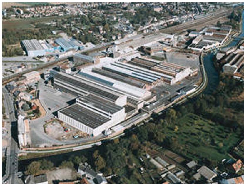
L'usine Jeumont Electric, en bordure de la Sambre.
