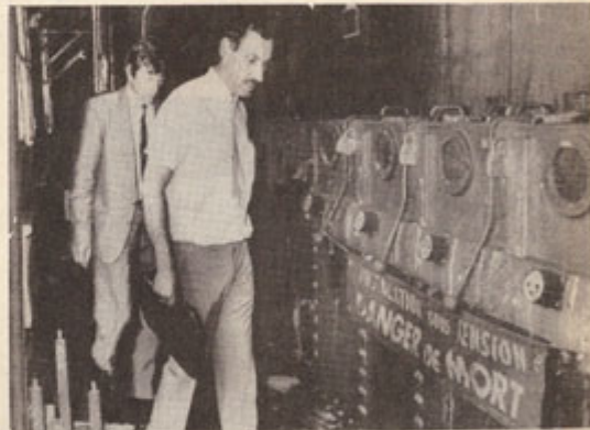
A l'intérieur du transformateur sinistré.
