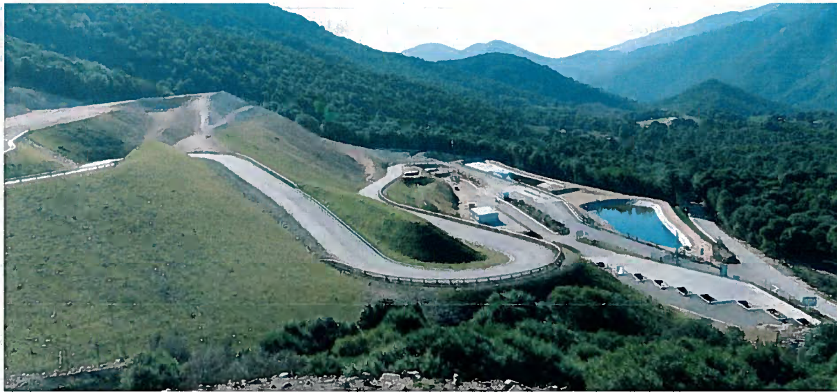
Pôle environnemental de Vico après réhabilitation
