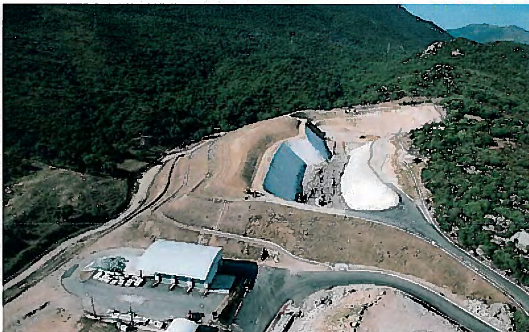
ISDND de Viggianello après réhabilitation
