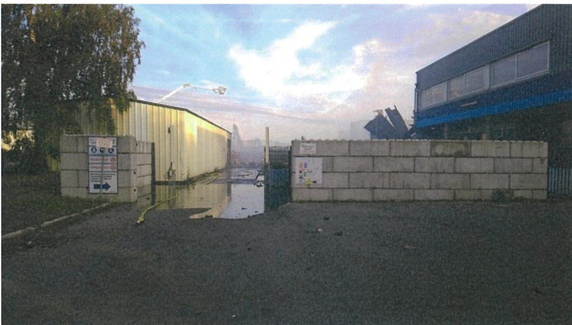
Illustration 5: Vue de l'intérieur du site de COGETRAD
