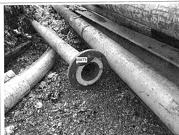
Prélèvement - MAT3 : Extérieur / Façade est - Joint de bride- (Absence d'amiante)
