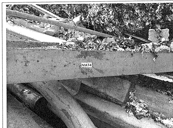
Prélèvement - MAT4 : Extérieur / Façade est - Peinture- (Absence d'amiante)
