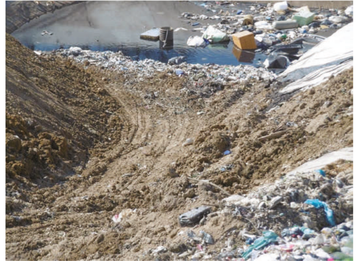
eaux d'extinction en fond de casier
