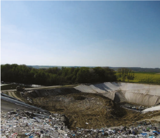
casier incendié - zone inertée
