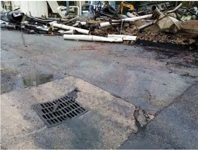
Illustration 7 : regard d'eaux pluviales
