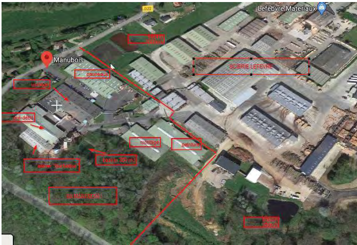
Illustration 1 : Vue aérienne des installations
