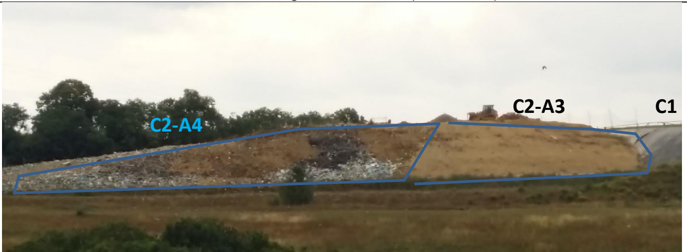
25/06 à 18h57 vue générale du talus Sud
