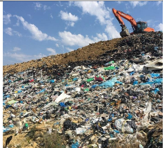
25/06 à 12h00, curage de la zone ayant repris
