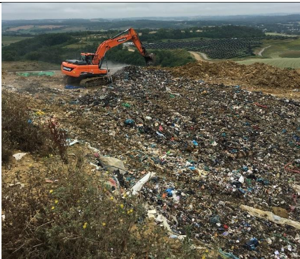
26/06 à 9h50, curage de la zone ayant repris
