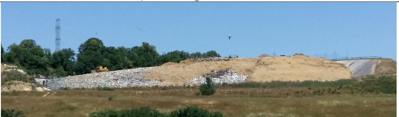
30/06 à 14h00 vue générale du talus Sud (zone hors exploitation, couverture provisoire en cours)
