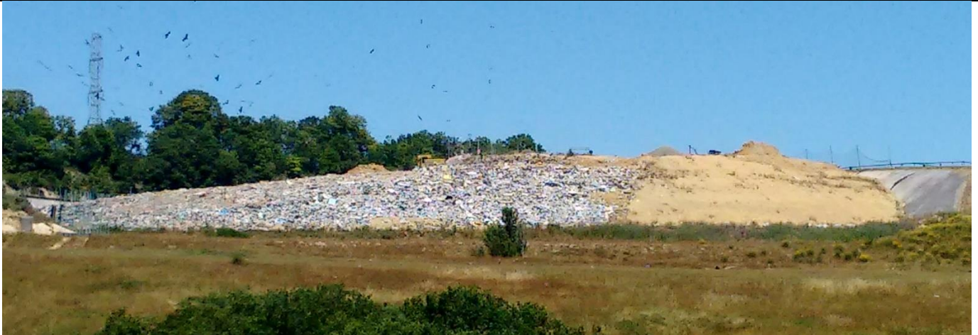
23/06 à 15h00 vue générale du talus Sud (avant incendie)
