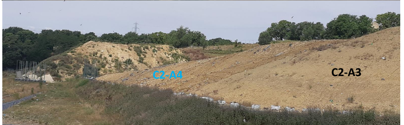
10/07 à 13h20 vue générale du talus Sud (zone hors exploitation, couverture provisoire finalisée)
