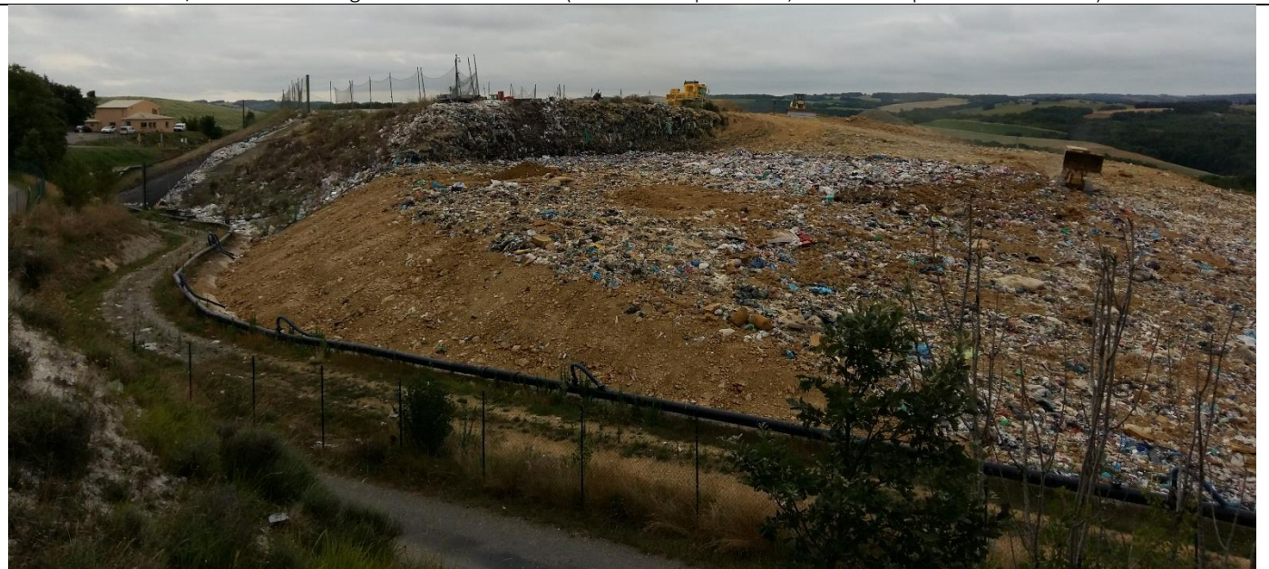
10/07 à 8h00 vue générale du talus Nord (zone hors exploitation, couverture provisoire finalisée, couverture hebdomadaire en cours)
