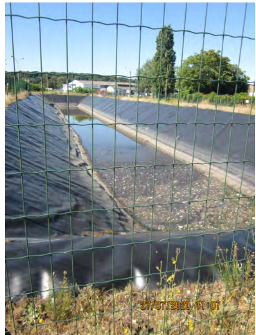
Photo 4 : Bassin de rétention
