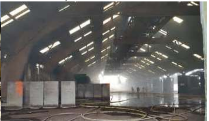
Illustration 3 : hangar B (depuis ligne de criblage)
