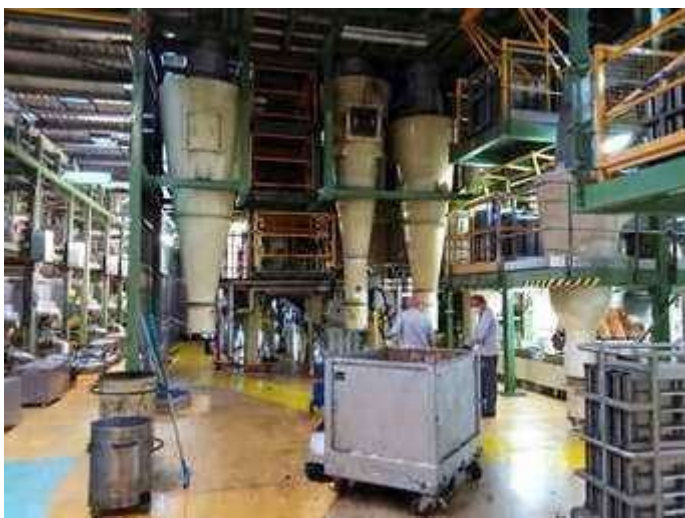
Illustration n°1 : vue ensemble torrificateur STT5
