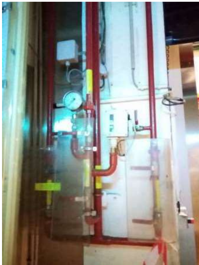
Illustration n°8 : commande sprinklage
