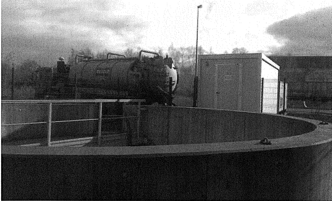
Photo 4 : Opération de pompage de la fosse – le 19/11/2020
