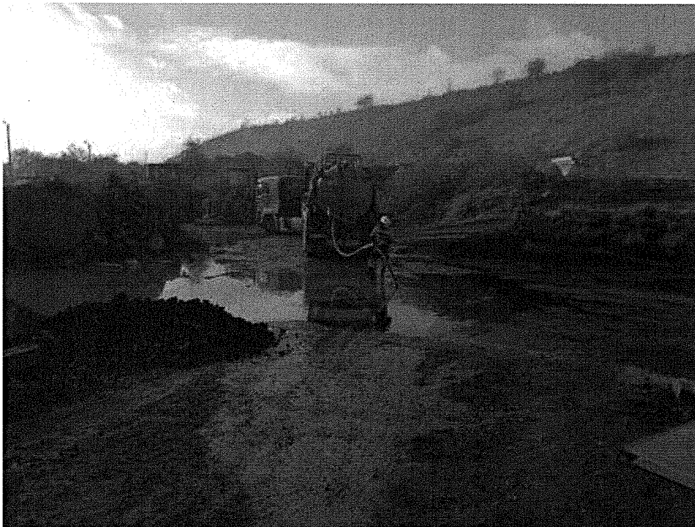
Photo 1 : Pompage à proximité de l'atelier – le 12/11/2020
