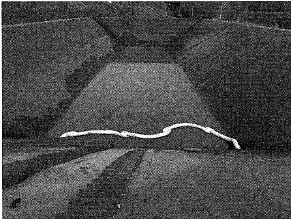
Photo 3 : bassin de confinement - le 12/11/2020
