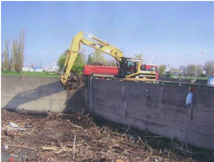
Exemple d'intervention (photo CNR avec l'ancien engin sans la nouvelle cabine mobile)
