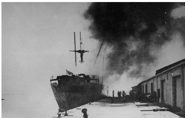
Tentative d'extinction du Grandcamp .
