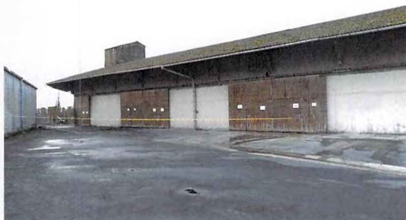
Bâtiment engrais – côté tour
