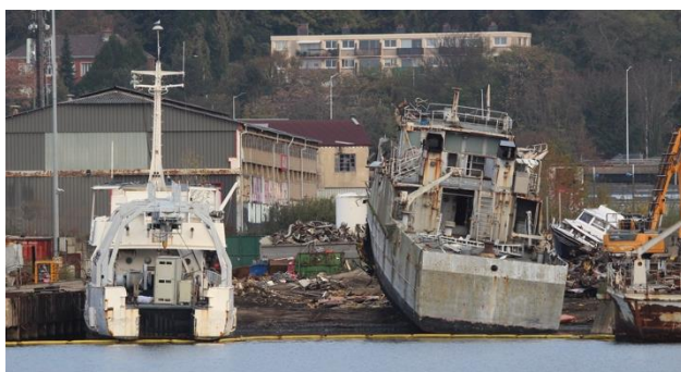
Denti (à gauche), Sterne (à droite), 9 août, en cours de démolition. © Pascal Breidel
