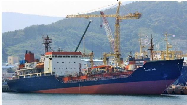
En réparation au chantier Orient du port de Gamcheon, Busan (Corée du Sud), 24 juin 2018. © Vladimir Tonic
