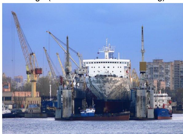
Novembre 2012, Chantier naval de Kanonersky, Saint-Pétersbourg. © kifir239
