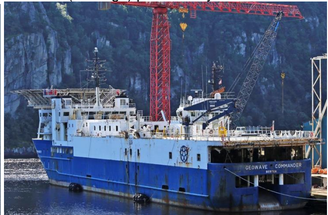
Chantier de démolition Greenyard à Feda (Norvège), 4 août 2021. © Øystein Berge - Maritime
