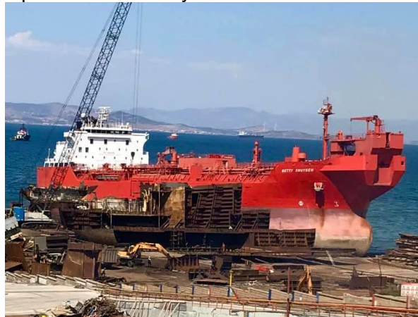
Chantier de démolition. Aliaga. © Selim San
