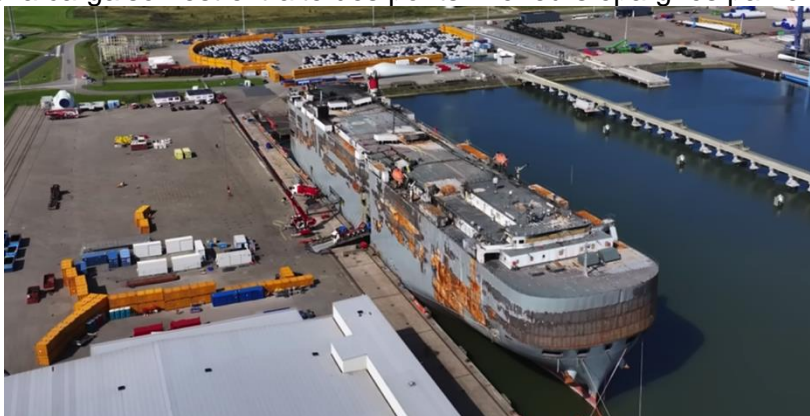
Le Fremantle Highway à Eemshaven, août 2023. © Eemskrant
