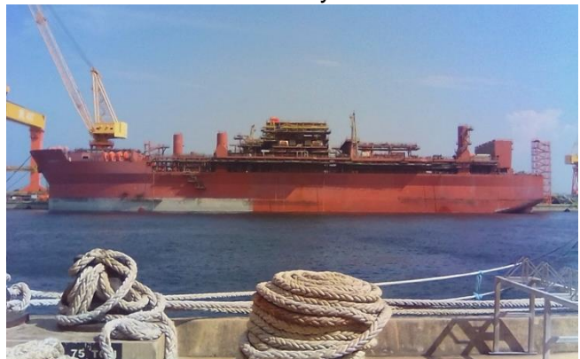
Camburi , juillet 2017, construction à l'arrêt. © Robert Radziszewski
