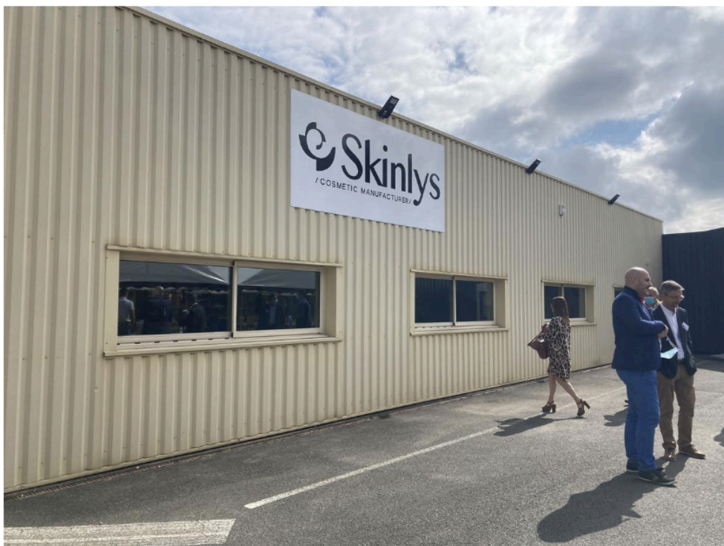
📷 D'importants travaux de mise aux normes et de rénovation ont été effectués. Marjorie Ansjon
